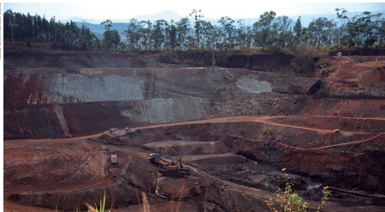
Caminhões trabalham na descaracterização da Barragem B3/B4 da Vale em Nova Lima, região metropolitana de Belo Horizonte
