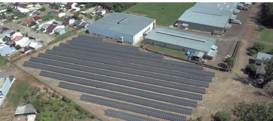
Usina solar da Mercur em Santa Cruz do Sul | Mercur solar plant in Santa Cruz do Sul
