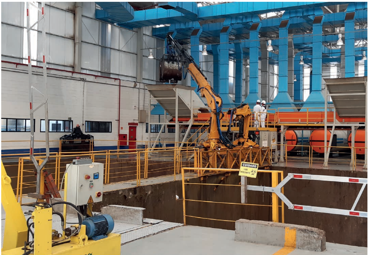
Unidade de Tratamento de Resíduos dos Serviços de Saúde construída em São Paulo e que entrou em operação em 2015 Services Waste Treatment Unit built in São Paulo and started operating in 2015
