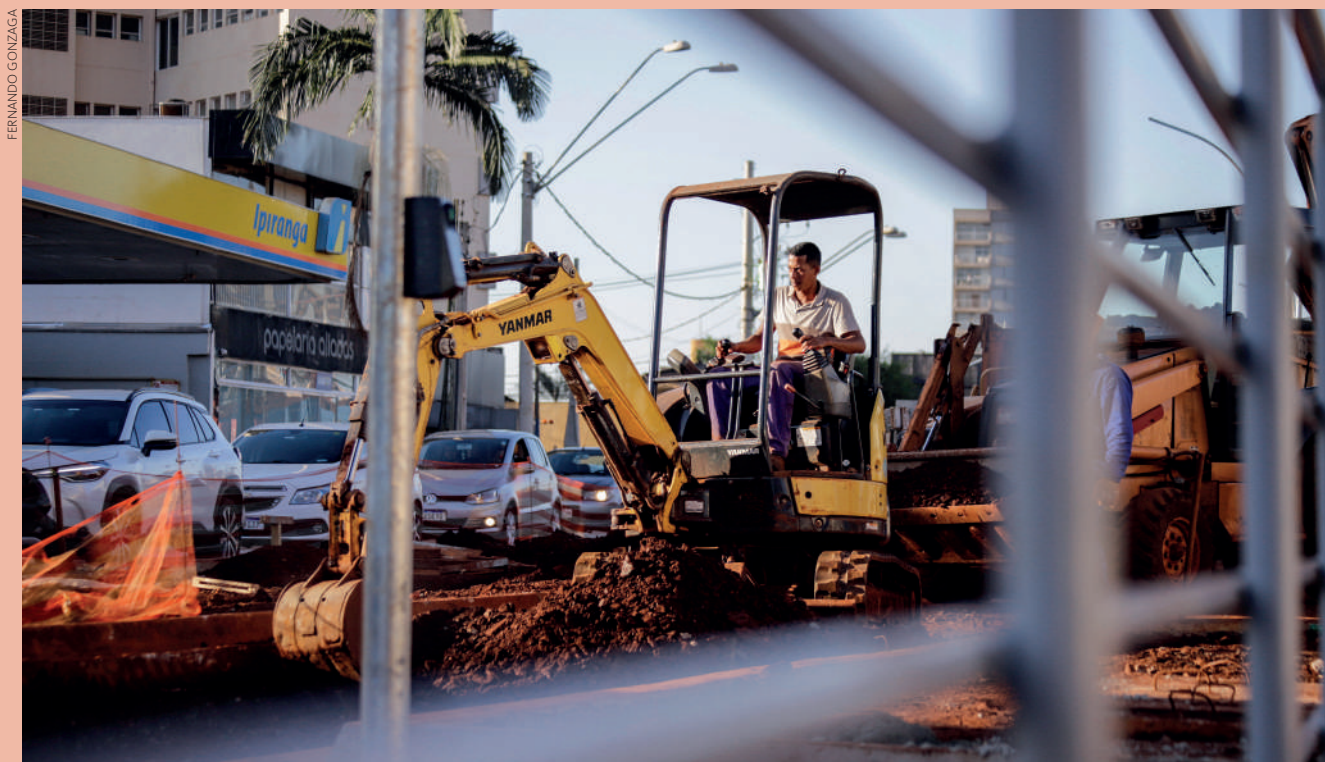
Emprego no setor da construção é um dos que mais sobe em Ribeirão Preto neste ano
